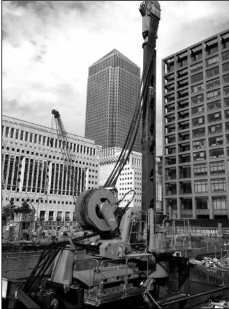
Fig. 11.17. Crush piler.
