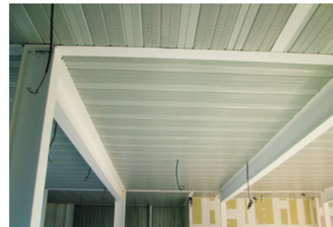
Soffit of Cofradal® Decibel
